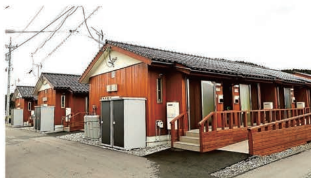
能登半島地震で建設された木造仮設住宅（2024年12月）
