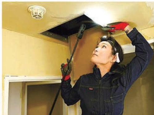
点検口から目視で天井裏を確認する住宅診断士
