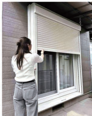
掃き出し窓の雨戸を撤去し、新たにシャッターを取り付けた。
