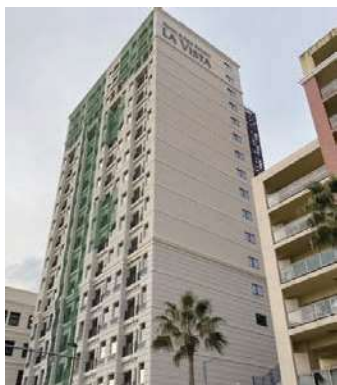
熱海サンビーチに面した好立地で建設が進む共立メンテナンスの新ホテル
