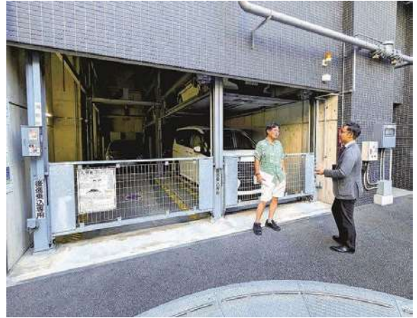
▲サブリースで貸し出している機械式駐車場
