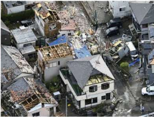
突風被害で壊れた建物（牧之原市）
