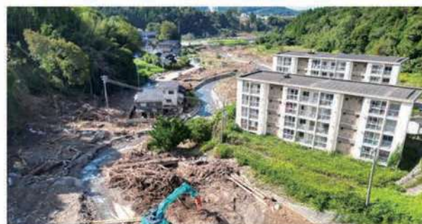
流木などで流れが変わり、周辺家屋に被害が発生した。(輪島市・塚田川)
