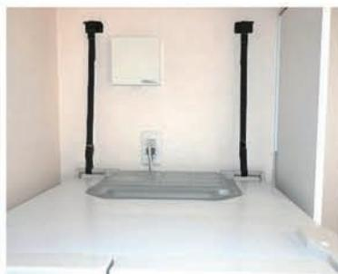
背面にある取っ手にベルトを通して、壁と固定する冷蔵庫の転倒防止策。
