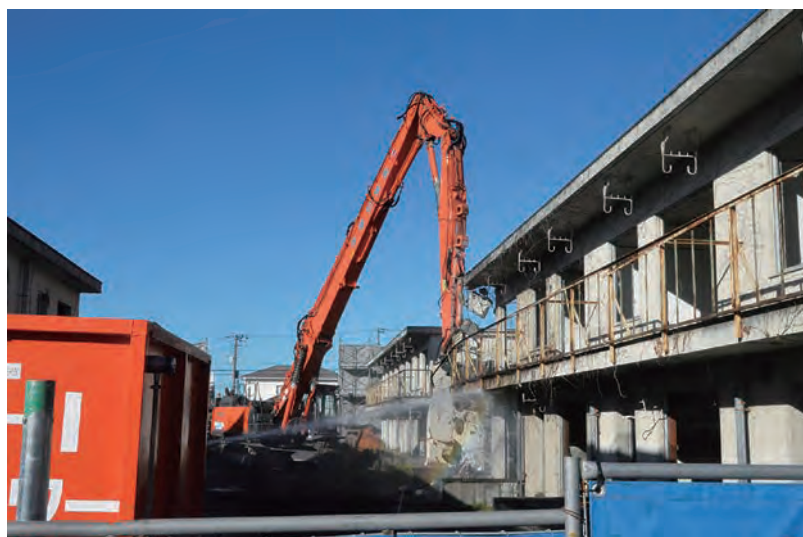
ＪＲ沼津駅高架化に関連した区画整理事業で始まった家屋の解体工事＝20日午後９時20分ごろ、沼津市富士見町
