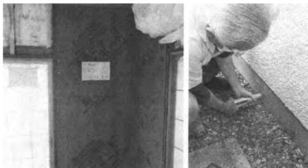
(右写真) 住宅の基礎の強度を測定する望月さん (左写真) 耐震ボードを組み込んだ壁(望月工務店提供)
