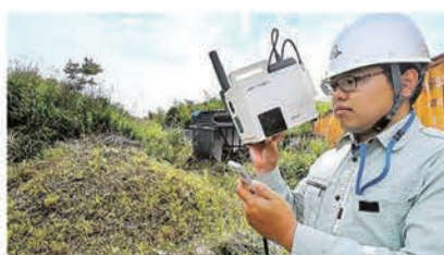
▲レーザー光を使った測定器で盛り土の規模を調べる県職員。
