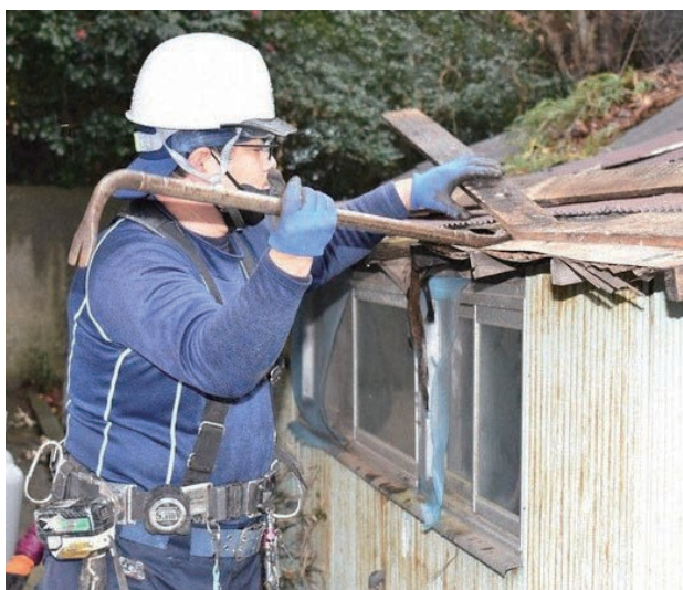
▲倒壊の恐れがある「特定空き家」を解体する作業員
