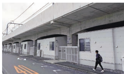
学生向け賃貸住宅「中央ラインハウス小金井」は、JR中央線の高架下にある(東京都小金井市で)
