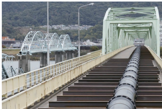
▲崩落した水道橋に並行する県道の端に設置された仮設の水道管
