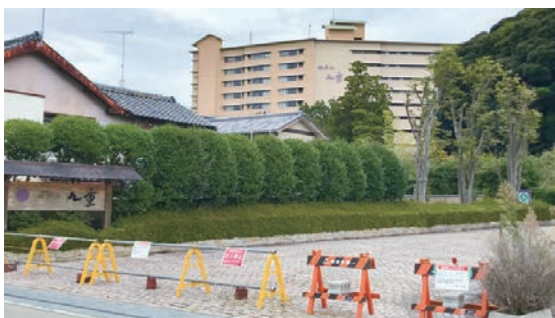
ホテル九重（奥の建物）は11月から2年間かけて解体する
