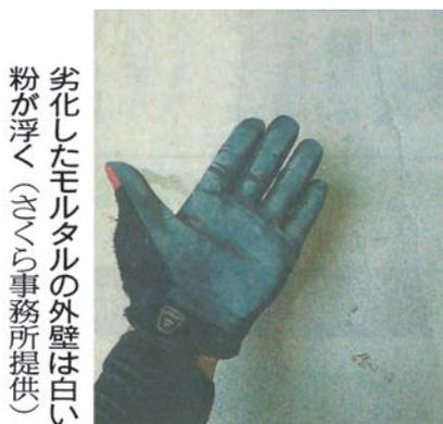
目地を押した際に弾力がないなら劣化のサインだ。約100㎡の2階建てなら、壁の再塗装や目地の交換で80～140万円程度の費用がかかる。
